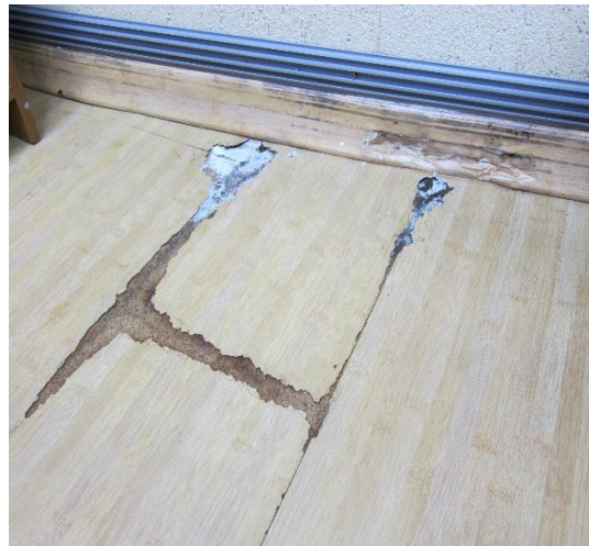
Foto 35 – Piso interno danificado devido à infiltrações
