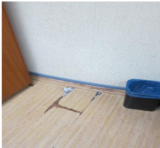
Foto 34 – Piso interno danificado devido à infiltrações
